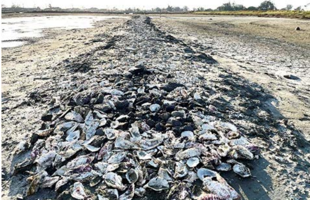
在土堤上鋪設蚵殼與碎石材料，增加透水性及通風度
