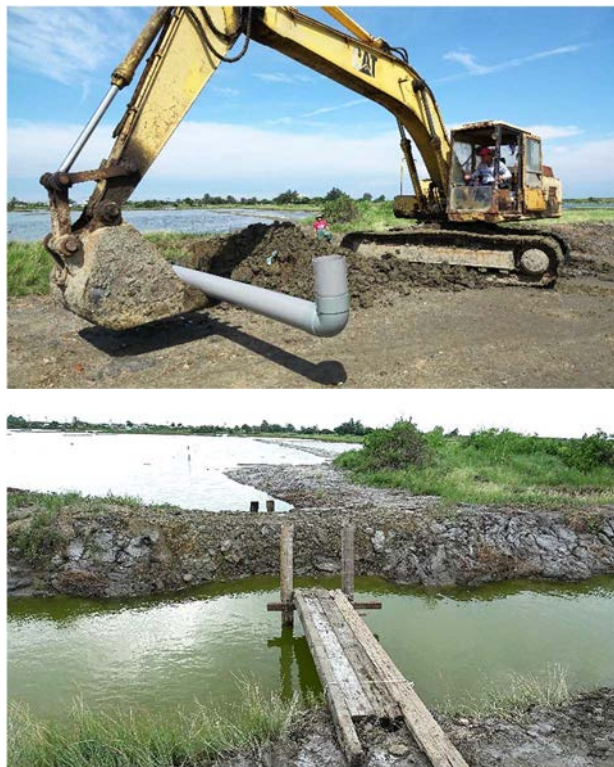
| 10-7 東側土堤埋設 PVC 管連通管，藉由內外溝水位差，營造鸕鶿類覓食的環境，同時為管理水位還搭了座木橋
