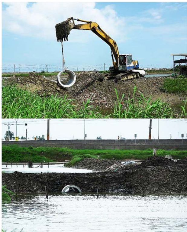
| 在漁民同意下開挖便道、重新埋設水泥涵管並進行溝底疏濬，讓 9 區的水可以排出
