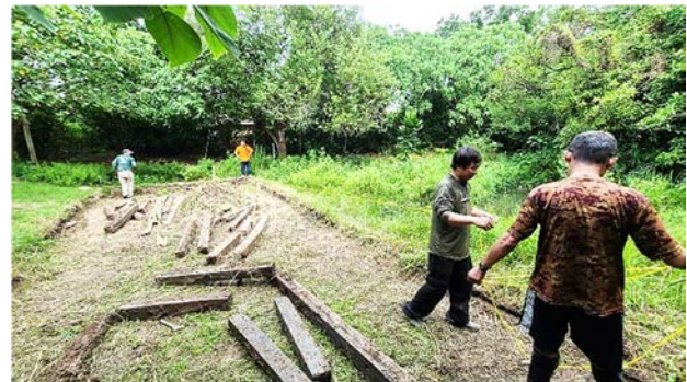
| 重新修建稻田區邊緣擋土堤與田埂路
