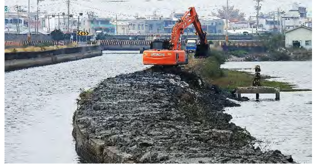
| 緊急搶修新塭沿岸支流堤防，以解除潰堤危機
