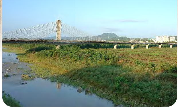
| 旗山橋是旗山地理景觀，設計單塔脊背橋
