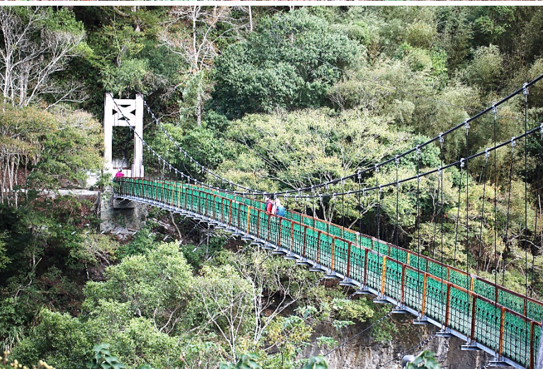
秀巒控溪吊橋
