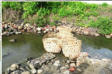
| 4-5、將竹子先去化竹節且外層打孔，再串連並排的竹簍；6、蚵殼濾水器的攪污效能很好，高程差讓水產生曝氣效果
