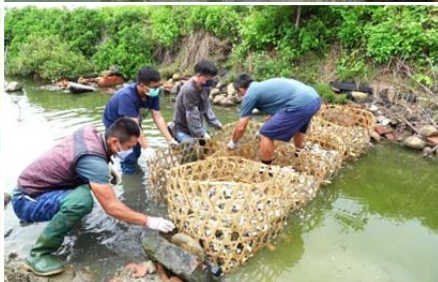
| 4-5、將竹子先去化竹節且外層打孔，再串連並排的竹簍；6、蚵殼濾水器的攪污效能很好，高程差讓水產生曝氣效果
