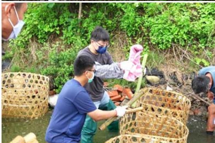
| 4-5、將竹子先去化竹節且外層打孔，再串連並排的竹簍；6、蚵殼濾水器的攪污效能很好，高程差讓水產生曝氣效果
