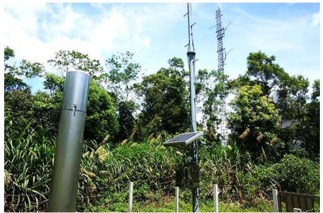
壽卡自動雨量站，設有 CCTV 監控儀器
