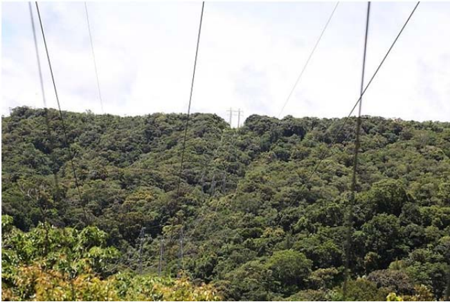
| 從 84 號鐵塔遠眺 83 與 82 號鐵塔
