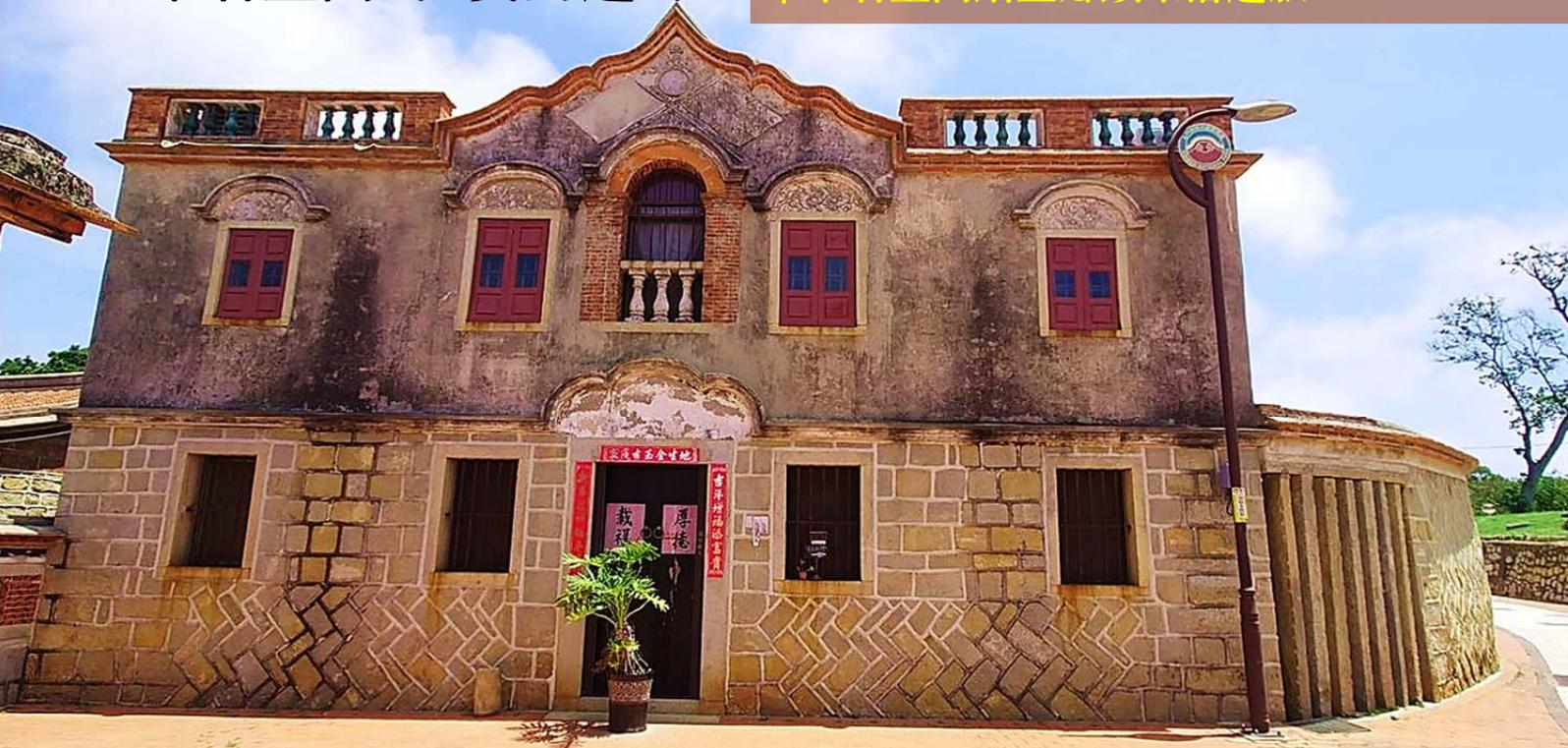
歐厝聚落〈歐陽鐘遠洋樓〉於 1916 年興建，歷時二年，在當時是歐厝第一棟洋樓。二樓正面人字山牆有雙獅啣寶鏡浮雕，窗櫺上也有泥塑浮雕，雖為洋式建築但仍有中國式樣。一樓外觀採以花崗岩建築，看似堡壘著重防禦用，另一面為朝向內部的洋式五腳基建築。
