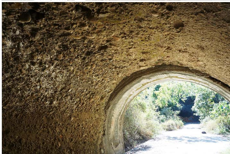
| 十八羅漢山的六號隧道仍保有礫岩地質結構，無水泥化
