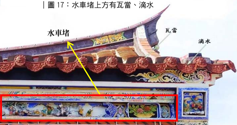
| 圖 17：水車堵上方有瓦當、滴水
