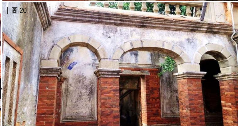
| 圖 19、20：都是在沙美聚落，一個閩式建築(上圖)，一個番厝(洋式，上石下磚，下圖)
