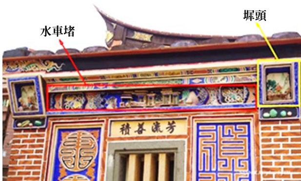
| 圖 15：立體浮雕水車堵下的鏡面堵有閩式建築傳統的雕磚
