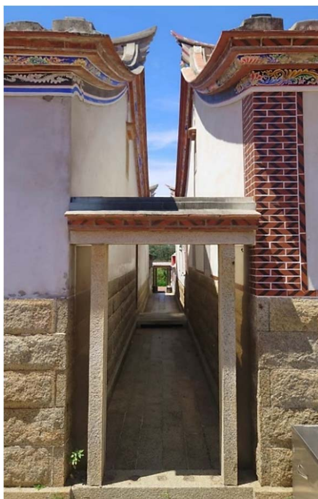
圖 7：前水頭聚落，隘門主要用於防禦，小型隘門結構簡單，遍佈街頭巷尾
