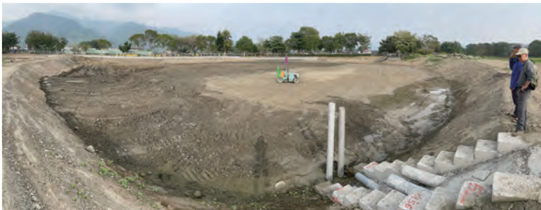
大灣棲地整理現況
