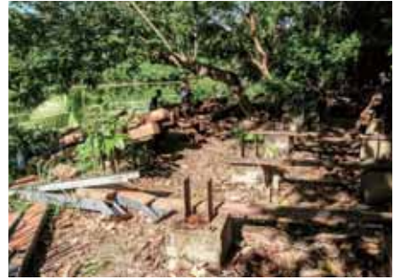
右側木棧道施工
