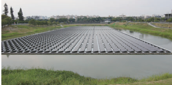
山仔頂溝滯洪池池面已架設了光電板
