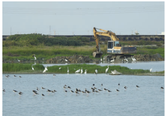
鹽田被排乾水後，一根根架設光電版的基樁插入土地深處
