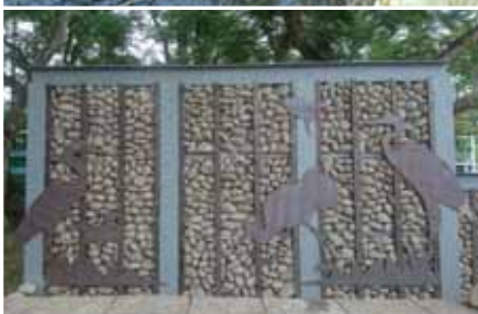
門口的石籠牆已安裝完成
