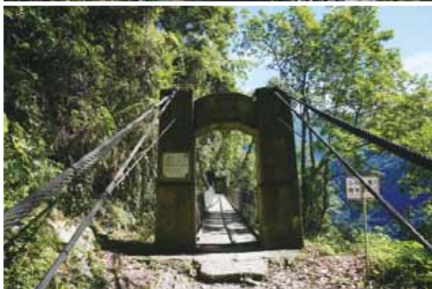
山風2號橋為檜木式橋
