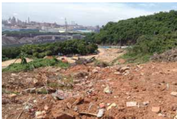
鳳山丘陵被違法開挖現場
