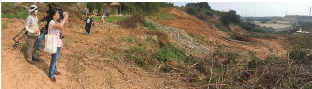
鳳山丘陵被違法開挖現場
