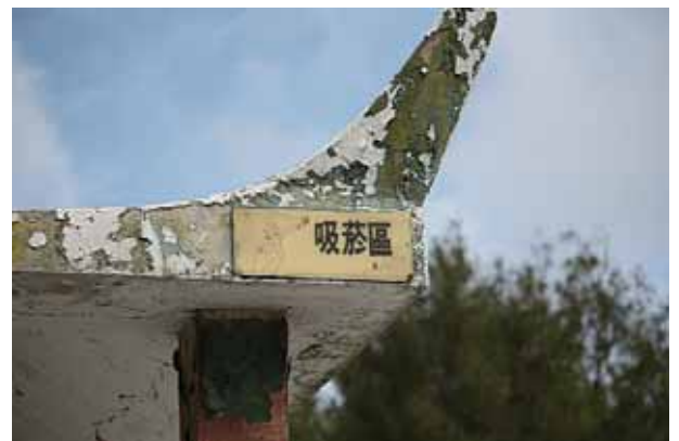
四角涼亭之吸煙區告示牌
