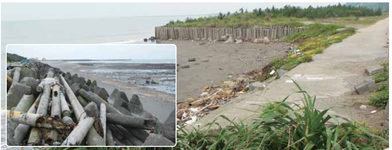
新屋鄉利用電線桿作為圍欄將石門水庫淤泥堆置於海岸，但海浪的力量把電線桿及淤泥捲入海中，然後再把電線桿推回岸上
