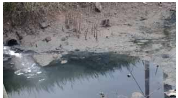
這個涵管旁還有暗管，冒著泡泡的水流入紅樹林內
